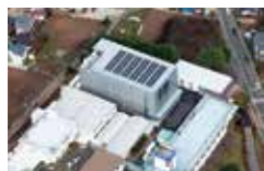
医療関連機器生産棟
