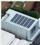
医療関連機器生産棟
