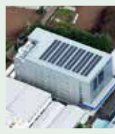
医療関連機器生産棟
